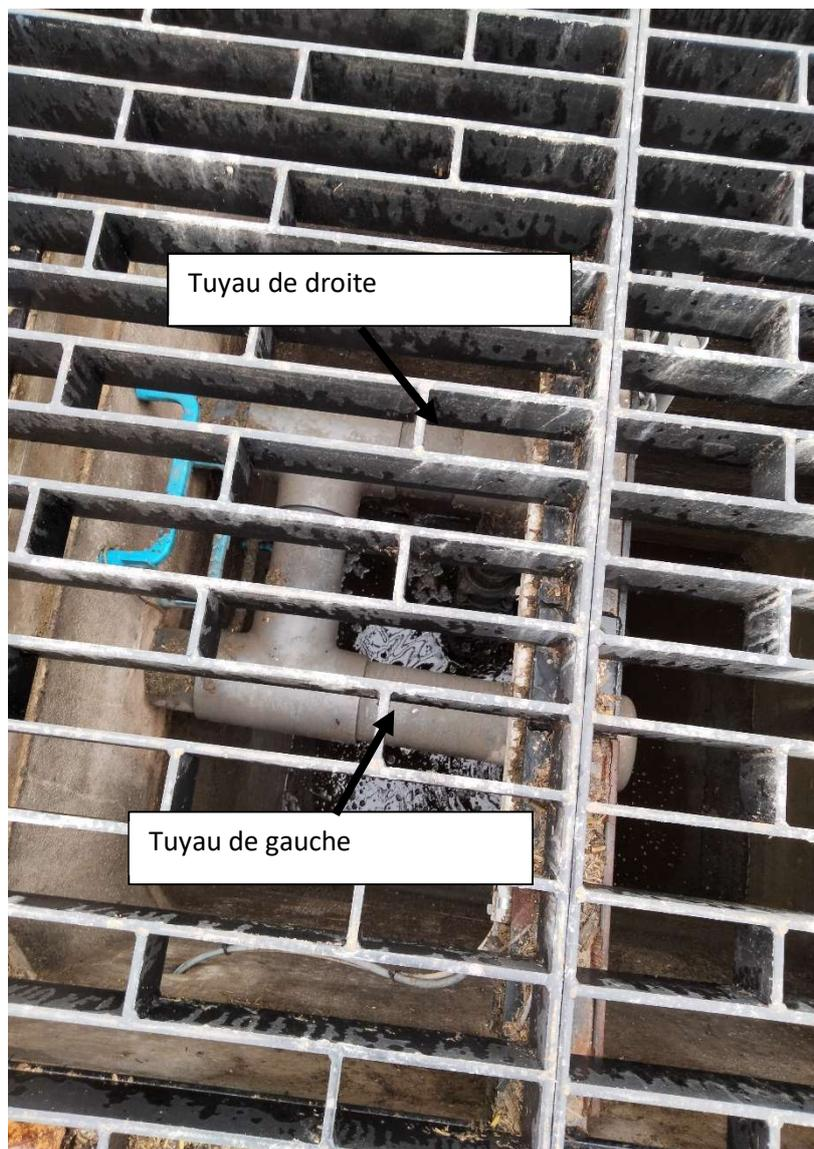
Le tuyau de droite, se divise en deux. Un tuyau part vers le bassin de décantation (tuyau sur lequel se trouve la vanne 2, qui est ouverte en fonctionnement normal), tandis que le deuxième débouche lui dans un regard avec un raccord pompier (tuyau sur lequel se trouve la vanne 1, qui est fermée en fonctionnement normal et qui est à ouvrir en cas d'incendie ou de pollution sur la voirie).
